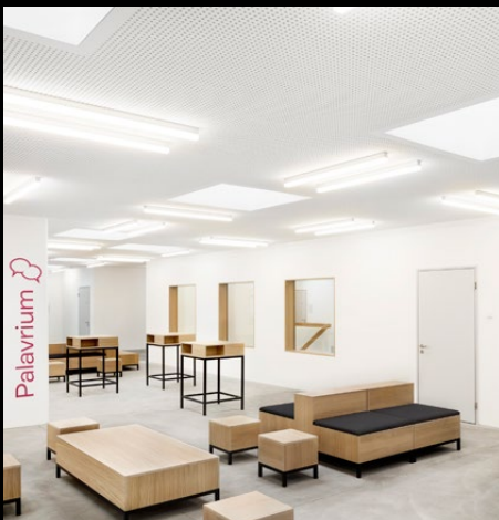
Begegnungszonen sowie Korridore: „Quadro“ Aufbauleuchte in Sonderausführung mit Spezialabdeckung aus Acrylglas opal.
