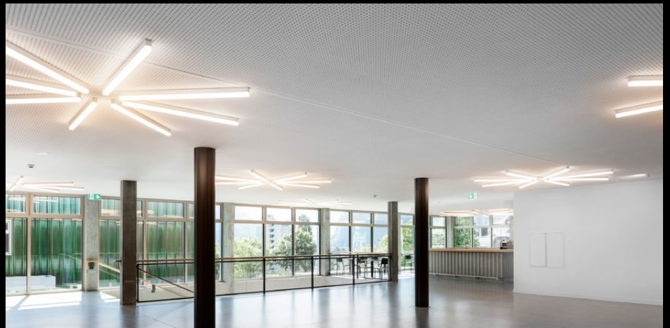
Foyer: „Quadro“ als Aufbauleuchte in Sonderausführung mit Spezialabdeckung aus Acrylglas opal.
