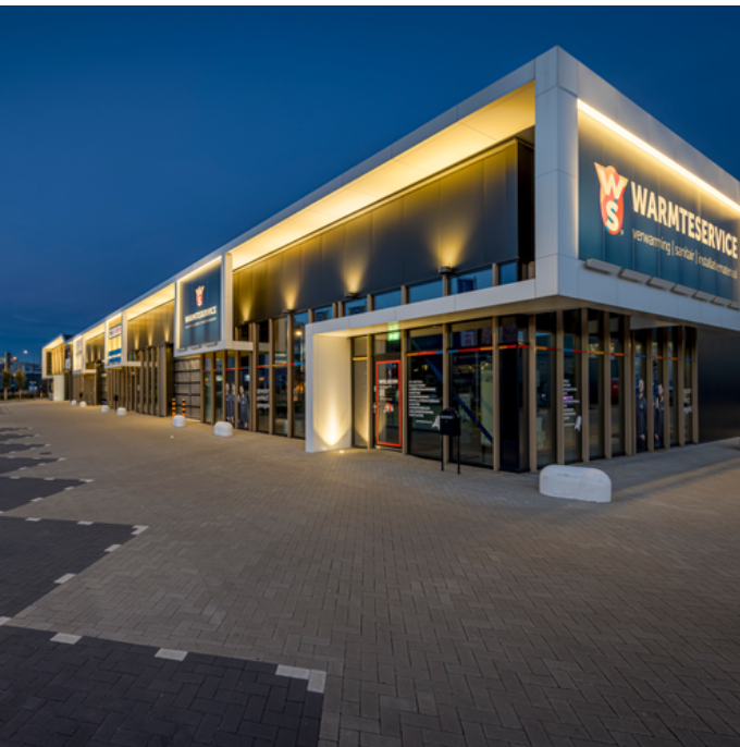
Gewerbliches Gebäude Warmteservice - Gouda - Niederlande
