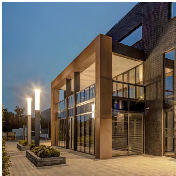
Neubau Elektrogrosshandel Robri - Wekerom - Niederlande
